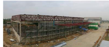
現在、増築工事中のタイ工場(2014年 9月完了予定)
